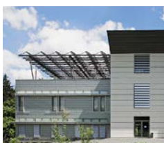
Ενεργειακό κέντρο Szentendre (Ουγγαρία)
